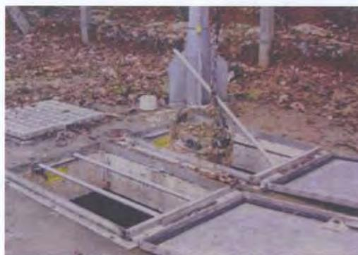
Trappes de Poste de relèvement munies de dispositifs de grilles anti-chute articulés :
