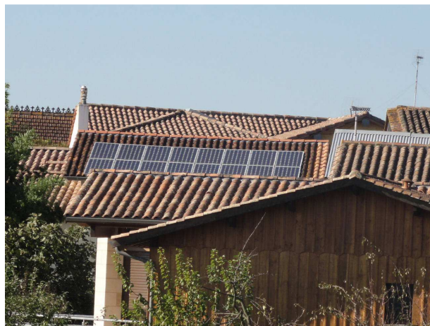
Toiture et capteurs solaires
